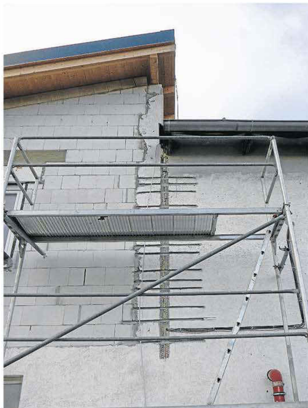
Nach der Instandsetzung bietet die Wand wieder den Schutz gegen Durchfeuchtung sowie den gewohnten Wärmedurchlasswiderstand.
