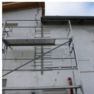
Fotos: Rissverpressung mit Spiralankersystem
