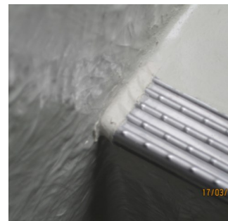
Während der Arbeiten
