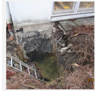
Probeöffnung an der Kelleraußenwand mit sichtbarem Grundwasserstand
