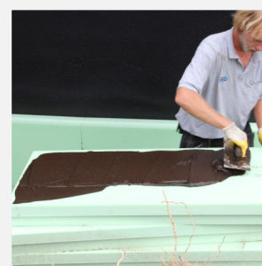
Vorbereitung der Perimeterdämmung durch vollflächige Verklebung der Dämmplatten
