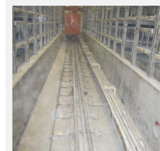
Nach der Verpressung - Trockener Gleiskanal
