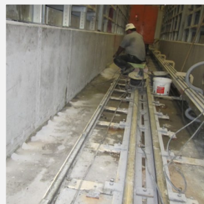
Während der Verpressarbeiten
