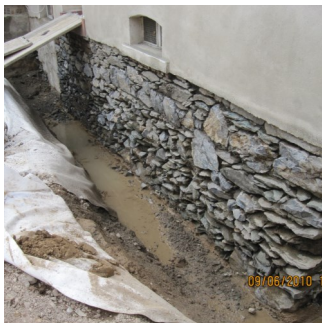
Reinigung der Wandfläche
