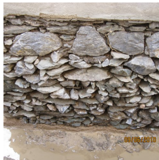
Sichtbar ist die starke Klüftigkeit der Bruchsteinwand
