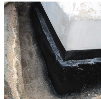
Fertige Abdichtung der Außenwand mit einer KMB-Abdichtung im Spritzverfahren
